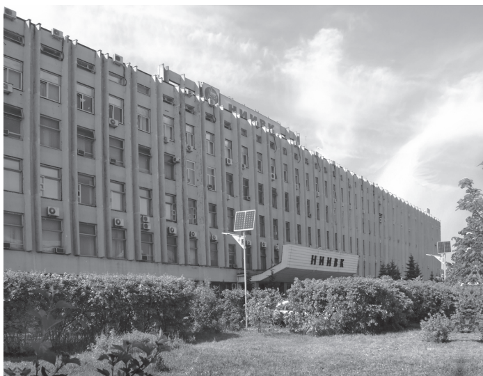
Рис. 1.15. Лабораторный корпус на Профсоюзной улице
